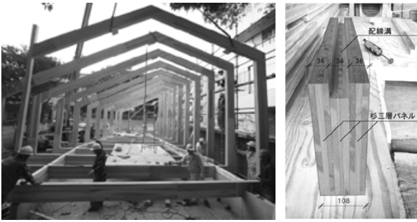
図2 建設中の実験住宅（左） フレームに用意された配線溝（右）
